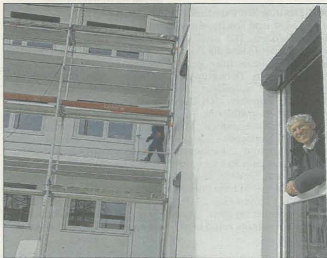
Besuch auf der Baustelle: Martin Bonz blickt aus dem Fenster seines zukünftigen Büros an der Riedheimer Straße. FOTO: Markus Fröse
