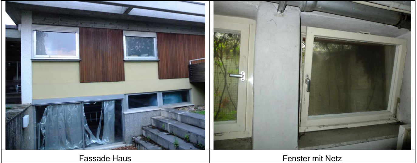
Abb. 4: Fassade Gebäude Raiffeisenstraße 1/1
